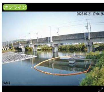
取水設備専用の監視カメラ
